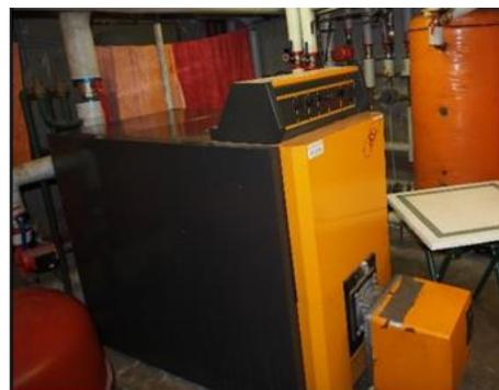
Distribution de chauffage : Les réseaux de chaleur sont calorifugés dans le sous-sol. Le réseau de distribution est vieillissant et de **nombreuses fuites existent** au niveau des émetteurs de chauffage allant jusqu'à dissuader le gérant de chauffer le bâtiment.
